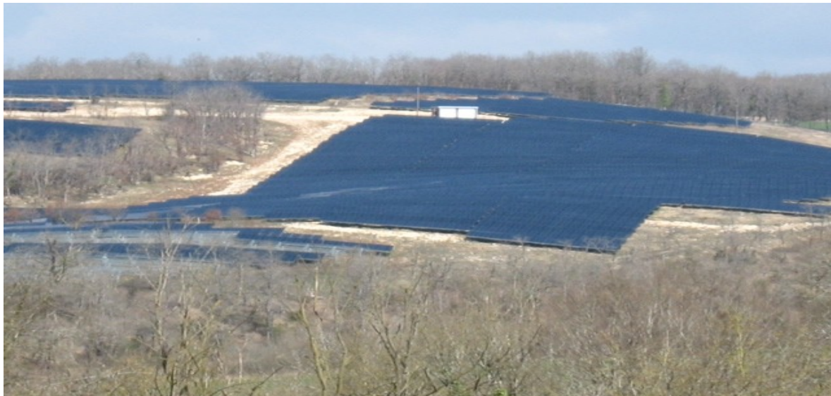
La centrale photovoltaïque de Sarrazac (Lot)
